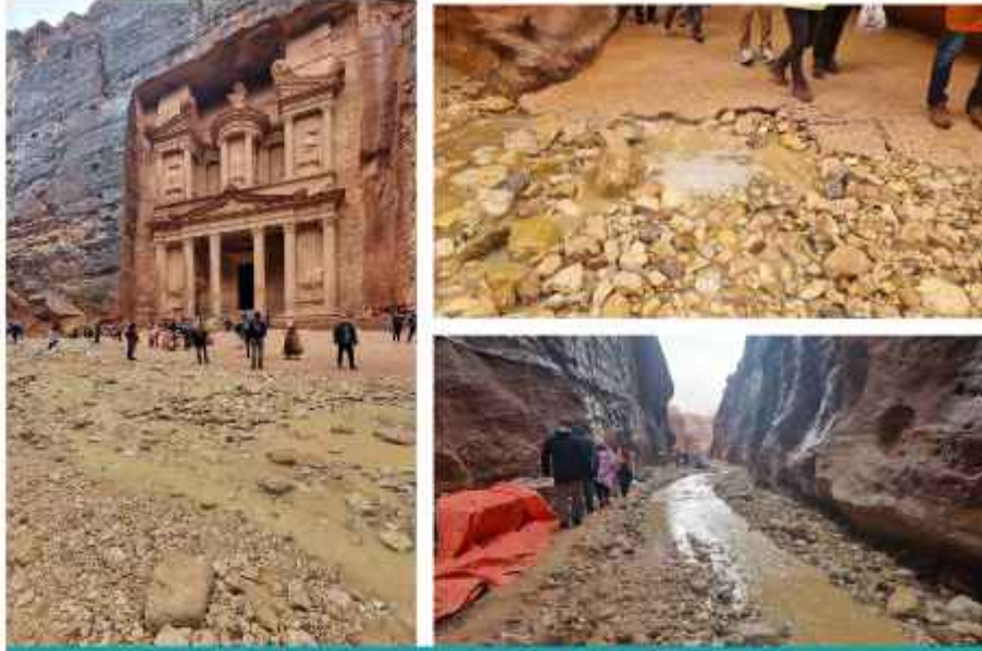
الشكل 31: صور تظهر آثار الفيضانات الأخيرة في موقع البترا الأثري (الصورة: طاهر فلاحات 2022)
