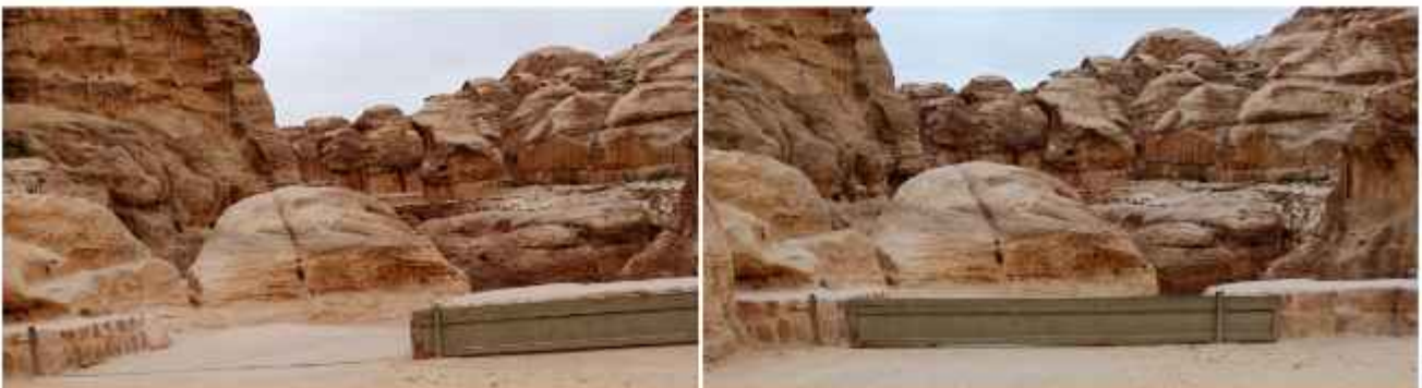
الشكل 35. العاجز القليل للسحب عند مدخل السيوي، مقروح (يسار) ومغلق (يمين) (تصوير مهدي روضيه، 2024)
