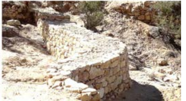
Dam 6 After re-construction السد 6 بعد إعادة البناء
