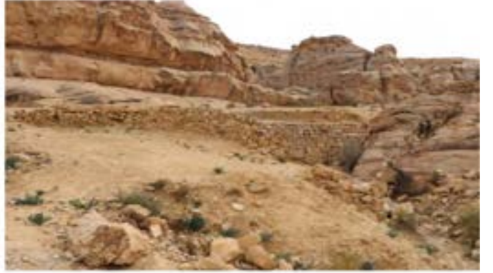
Dam 4 After re-construction السد 4 بعد إعادة البناء
