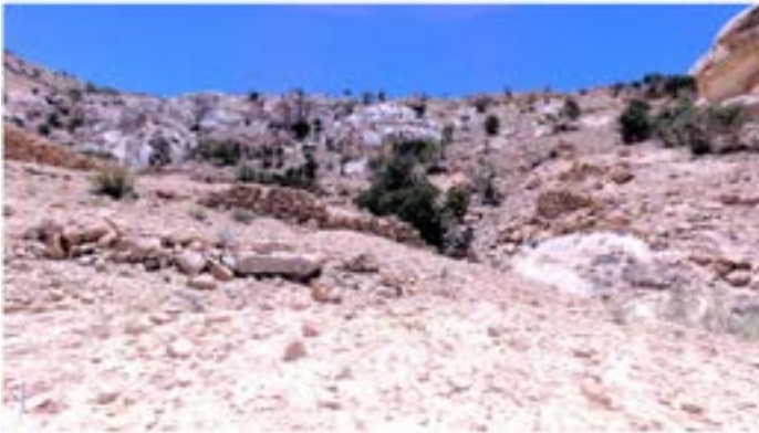
Dam 6 Before re-construction السد 6 قبل إعادة البناء
