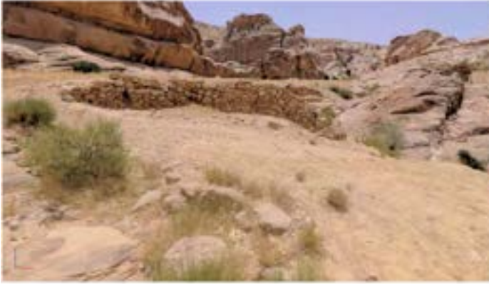
Dam 4 Before re-construction السد 4 قبل إعادة البناء
