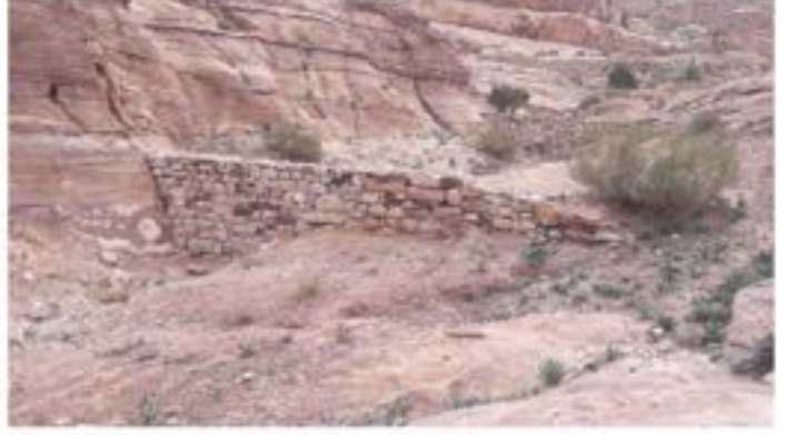
Dam 2 After re-construction السد 2 بعد إعادة البناء
